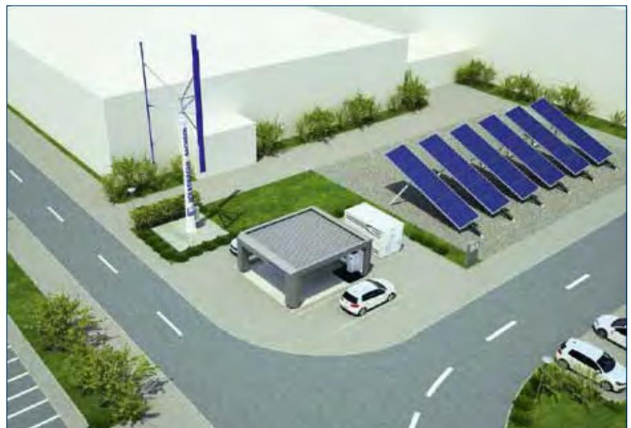
Im Energiepark von Volkswagen Sachsen in Zwickau werden Windkraft und Photovoltaik zur Energieerzeugung genutzt. Integriert ist eine E-Tankstelle mit zwei Schnellladesäulen und jeweils drei Ladesteckertypen. Mit 30 Minuten Schnellladung wird die Batterie zu 80 Prozent aufgeladen.
