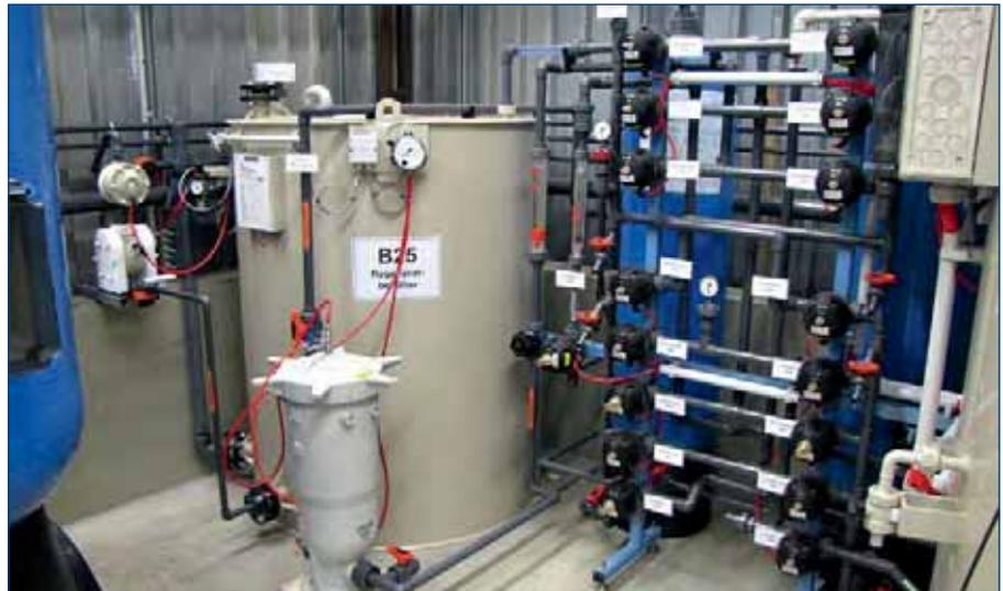
Anlage zur Nickelrückgewinnung aus Eloxalbädern.
