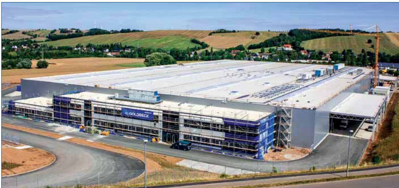
In Reinsdorf bei Zwickau wächst ein neuer Standort von Meleghy Automotive. Hier wird der Automobilzulieferer zukünftig Komponenten für Fahrzeuge der MEB-Plattform von VW fertigen. Generalunternehmer des Bauprojekts ist Goldbeck.
