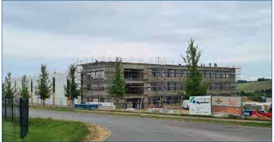
Im Gewerbegebiet Reinsdorf bei Zwickau entsteht der neue Unternehmenssitz der AKE Systemtechnik GmbH. Gemeinsam mit den Bauexperten von Goldbeck wird dabei ein nachhaltiges energetisches Konzept umgesetzt.
