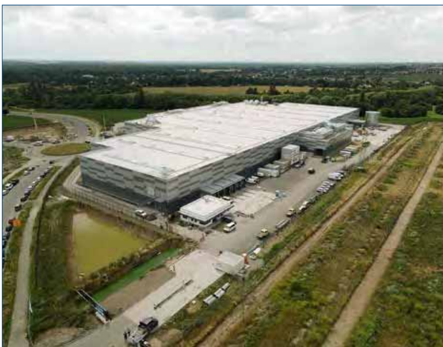
Blick auf das neue HV-Batteriewerk von Dräxlmaier im Metawerk-Park Leipzig.
