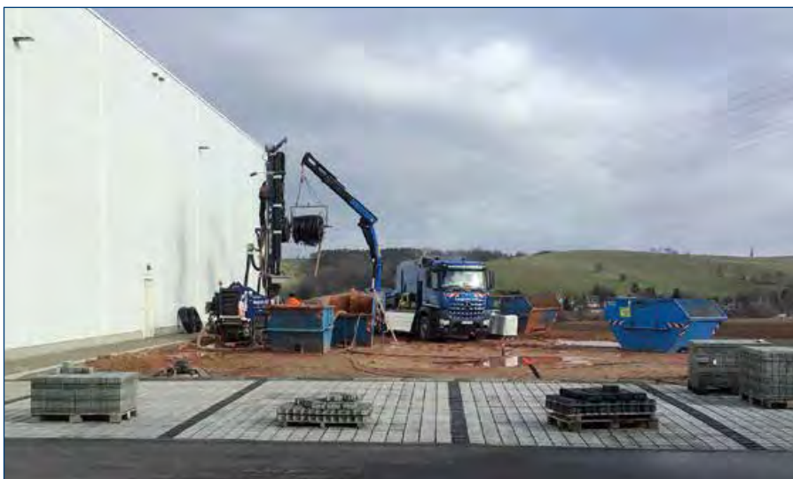
Im neuen AKE-Komplex wird Erdwärme zum Heizen und Kühlen genutzt. Dafür wurden 16 Bohrungen je 150 Meter tief in den Boden getrieben.
