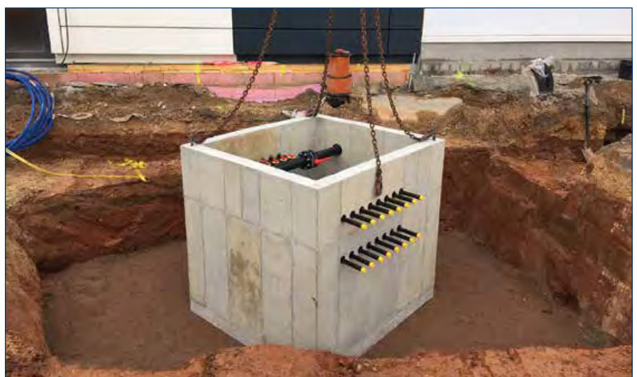
Ein Schacht zur Verteilung der Erdwärme wird auf dem AKE-Gelände gesetzt.
